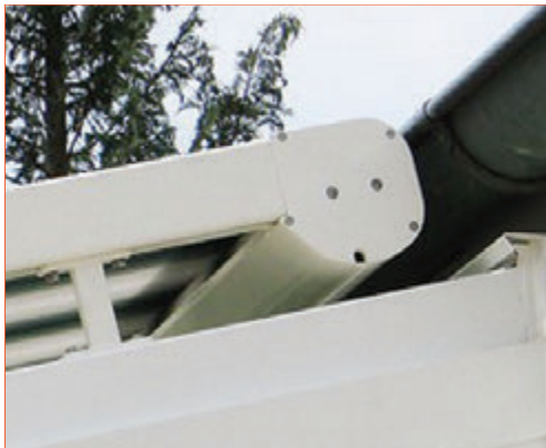
Protección de la lona mediante cofre.
