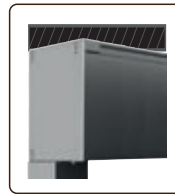
TECHO (Fijación Soportes)
